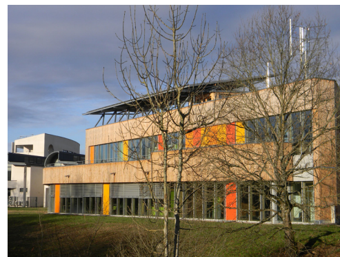
Maison des énergies - Héricourt (70)
