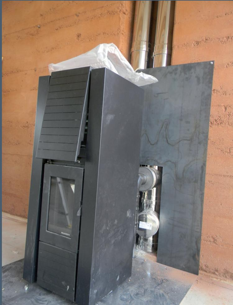
*Poêle à granulés hydraulique, un élément du dispositif de chauffage du bâtiment*
