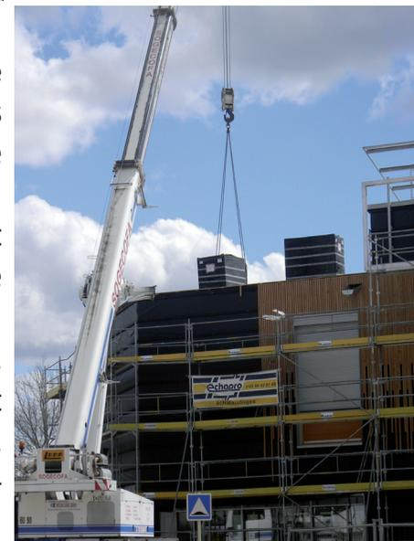
*Grutage des panneaux photovoltaïques sur le toit*
