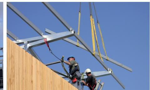
*Installation de la charpente métallique sur le toit*
