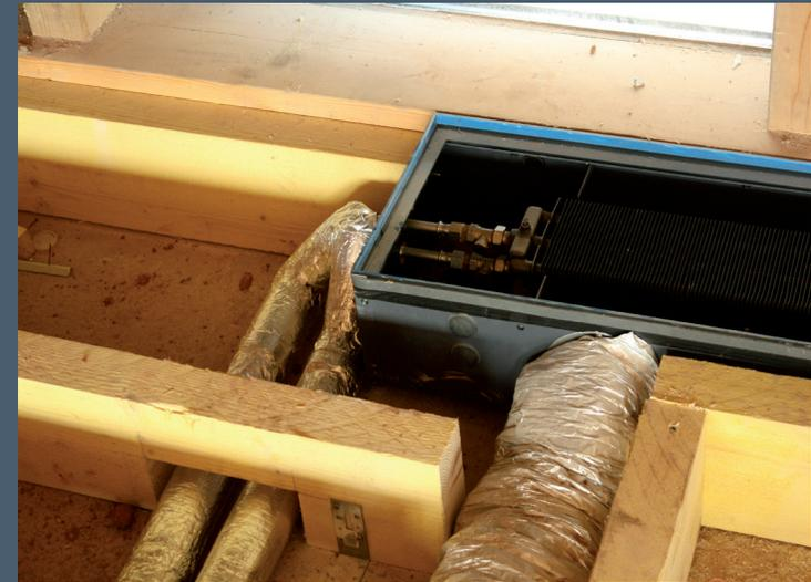
*Raccordement d'un radiateur à ailettes encastré dans le plancher*
