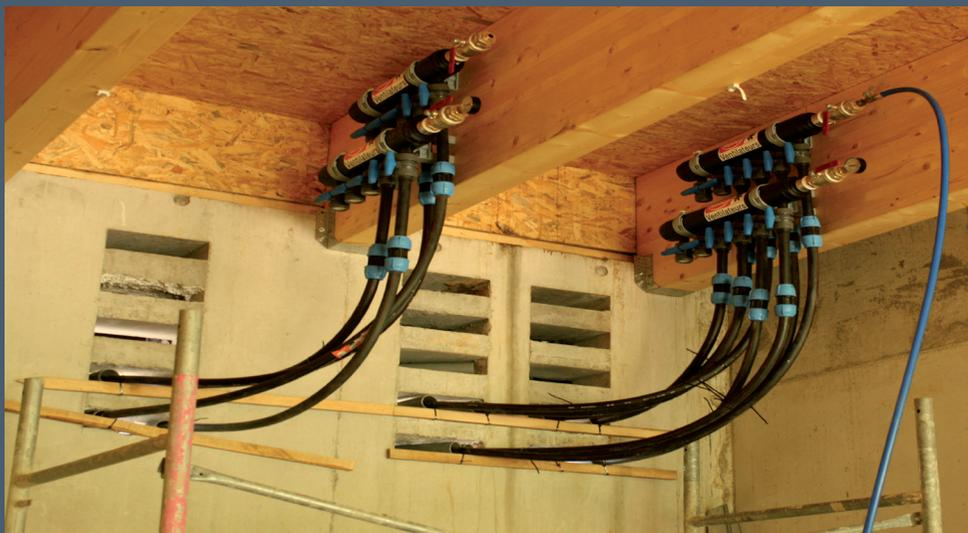
*Entrée des capteurs géothermiques dans le local technique depuis le talus*
