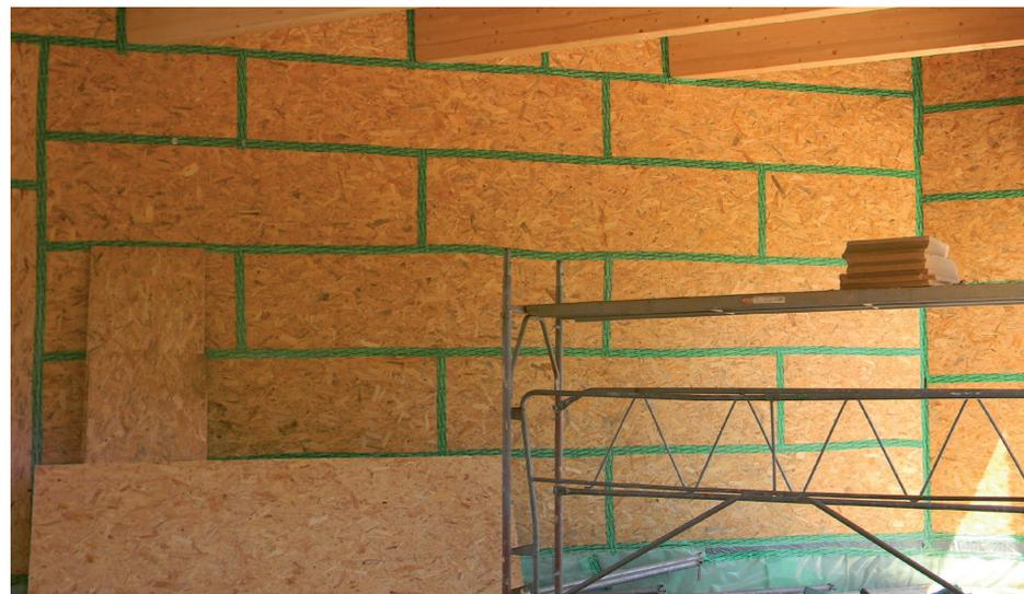
Etanchéité des murs avec des panneaux OSB raccordés entre eux par de l'adhésif et traitement de points singuliers
