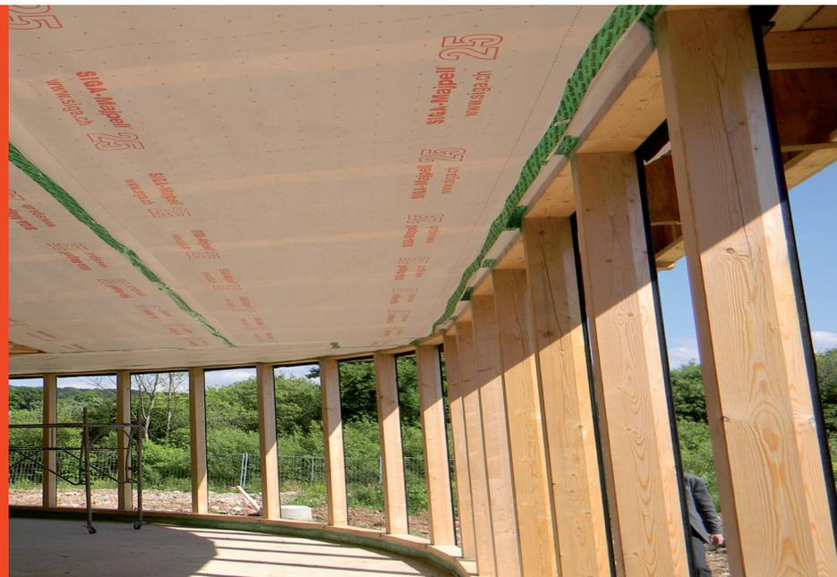
Etanchéité à l'air à l'intérieur du bâtiment
