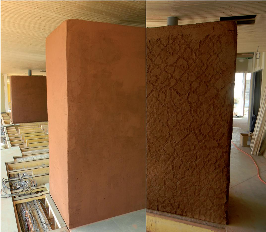
Pour monter ces murs de 90 cm d'épaisseur, des coffrages sont nécessaires. A l'aide de planches appelées «banches», ces coffrages en bois, confectionnés sur place, sont remplis de terre. Celle-ci est insérée par couches de 30 cm, tassées avec une dameuse pneumatique réduisant l'épaisseur à 20 cm. L'opération est renouvelée jusqu'à l'obtention de la hauteur souhaitée, ce qui explique les différentes couches visibles.
