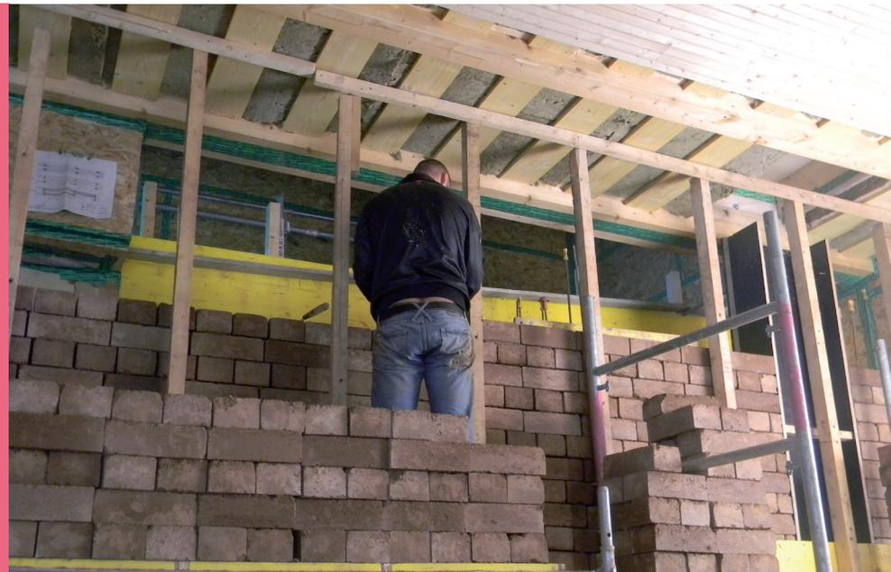
*Construction d'un mur en pisé en couches tassées puis en briques de terre préfabriquées*
