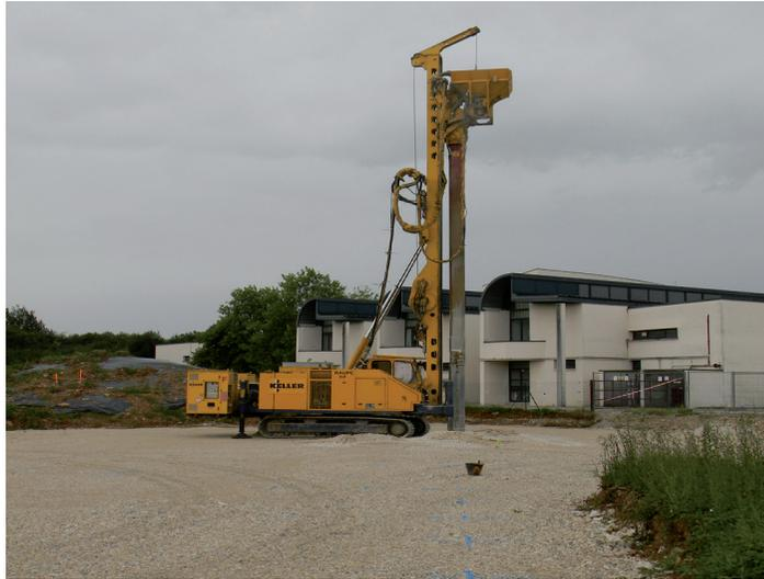
*Renforcement du sol par la technique des colonnes ballastées*
