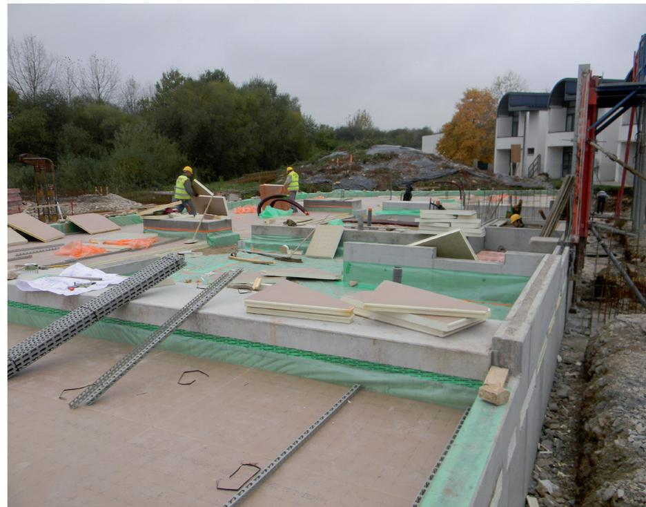
*Isolation sous dalle du rez-de-chaussée
