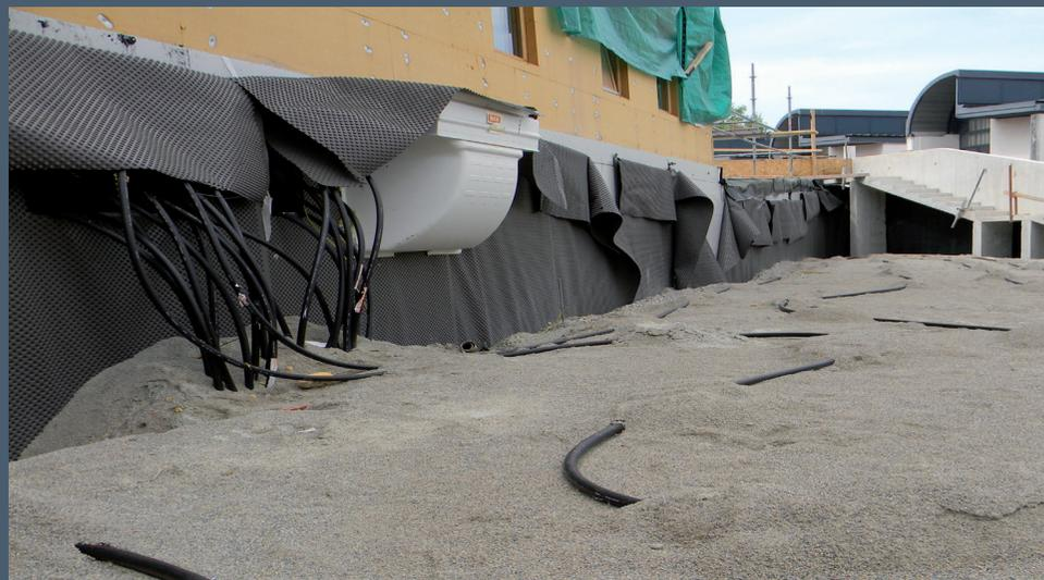
*Ensevelissement des capteurs géothermiques dans le talus*
