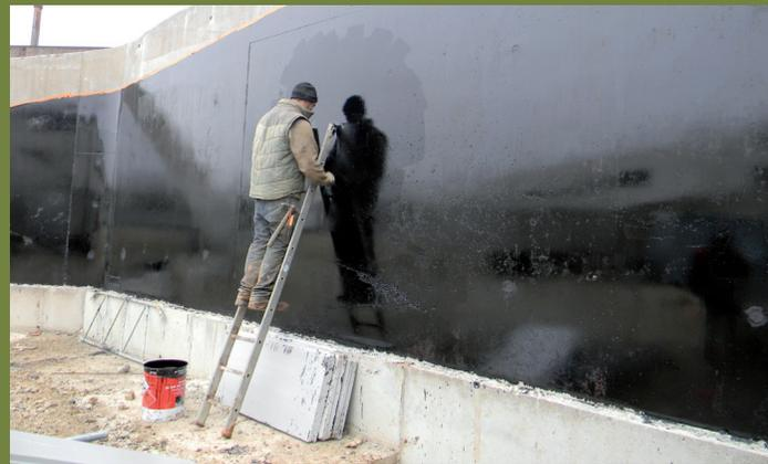
*Application de colle bitumée à froid pour isoler l'extérieur du mur enterré*
