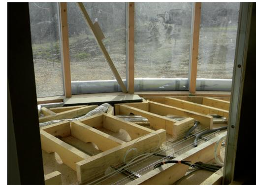
*Plancher technique en bois avant recouvrement par les panneaux agglomérés bois*
