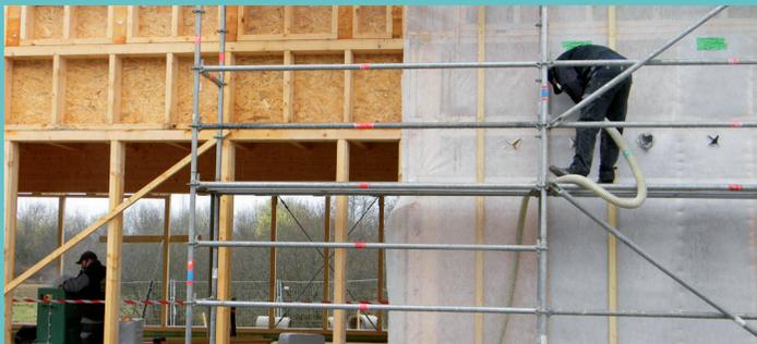
*Insufflation de ouate de cellulose dans l'ossature*
