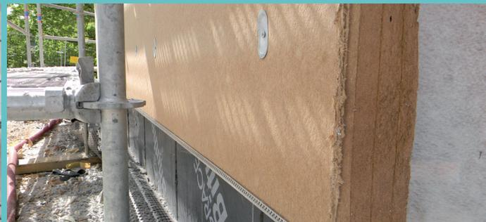
*Géotextile et fibre de bois en isolation extérieure*
