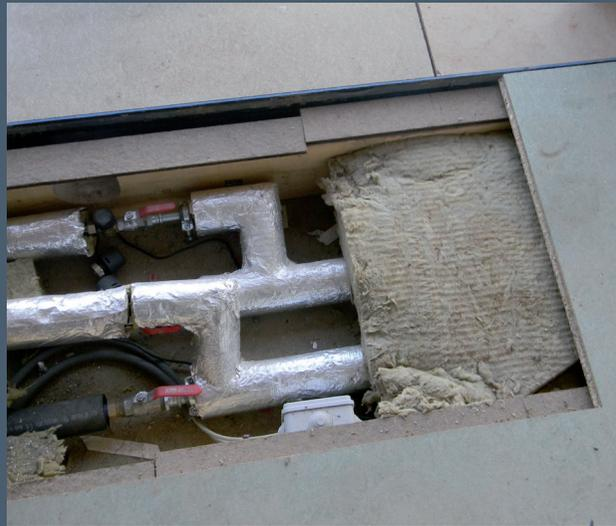
*Circulation des tuyauteries de chauffage isolées dans le plancher technique*
