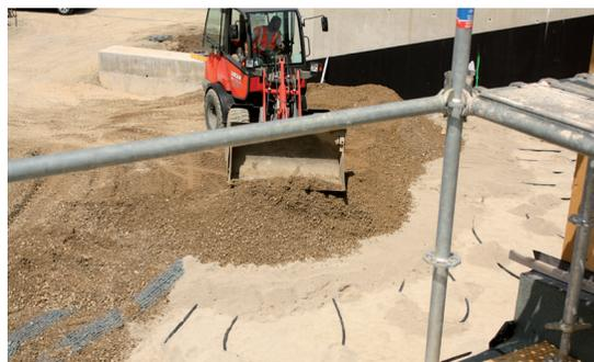
*Élévation du talus et enfouissement des capteurs*
