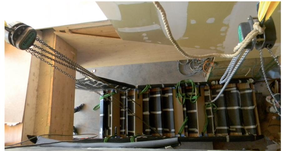
*Montage de l'escalier en chêne massif grâce à un système de levage par poulies*
