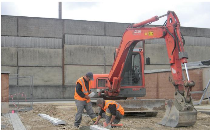
*Installation d'une bande de guidage au sol pour permettre l'accès des malvoyants*
