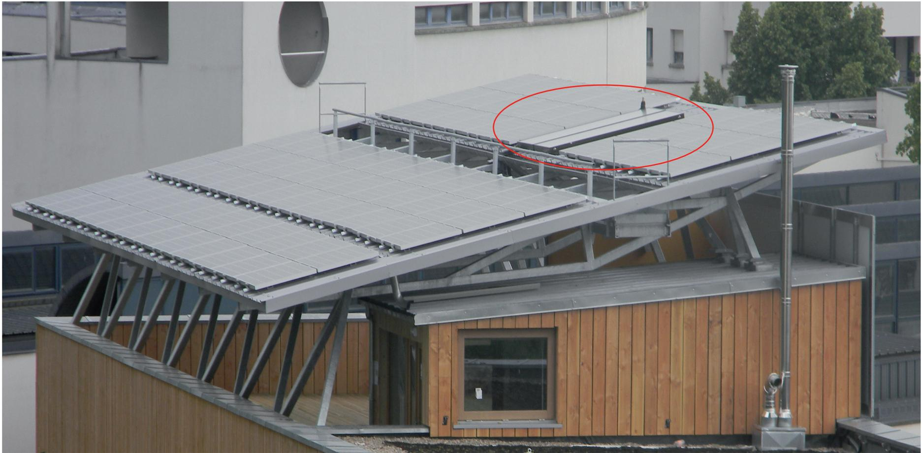
5 m<sup>2</sup> de capteurs solaires thermiques sont installés sur le toit de la Maison des énergies.
