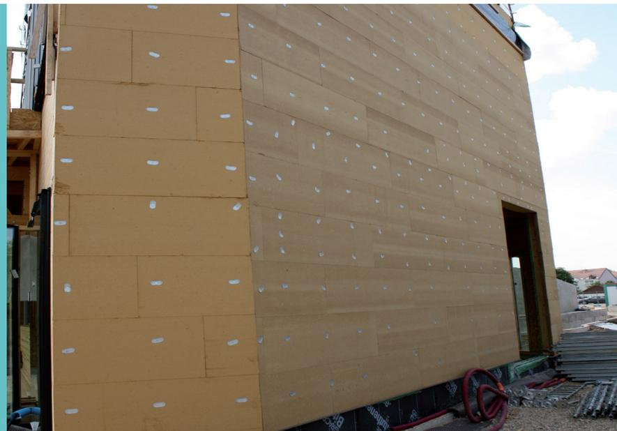
*Isolation extérieure du bâtiment après insufflation de ouate de cellulose et pose de panneaux en fibre de bois*
