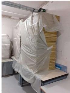
Plaques de faux-plafonds: dépose et conditionnement avec soin pour repose
