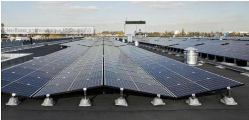
Une inclinaison d'au moins 10° permet un auto-nettoyage du module plus efficace
