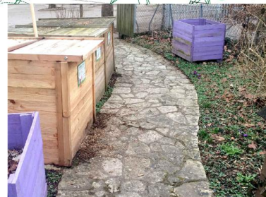
Revêtement en pierres opus incertum
