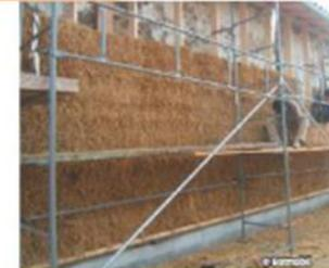
L'isolation thermique par l'extérieur permet d'isoler a posteriori, un bâtiment déjà construit. Les bottes de paille sont collées au mur existant ou bien sont insérées dans une ossature secondaire elle-même fixée au mur existant.
