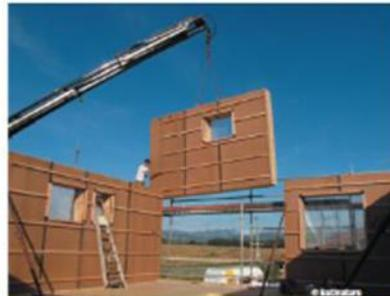
Le principe est de préfabriquer des caissons et de les remplir en atelier avec des bottes de paille.
