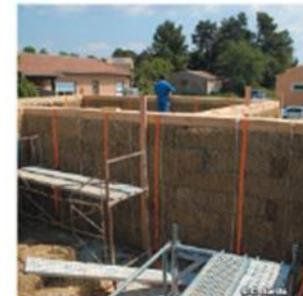
La botte de paille a ici un rôle structurel en plus d'être un isolant thermique. Il n'y a pas d'ossature bois, ce sont les bottes de paille qui portent la charpente.
