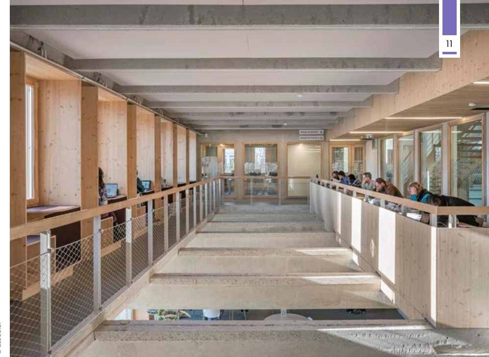
Une partie des planchers a été évidée pour favoriser la ventilation naturelle et la qualité des ambiances.
