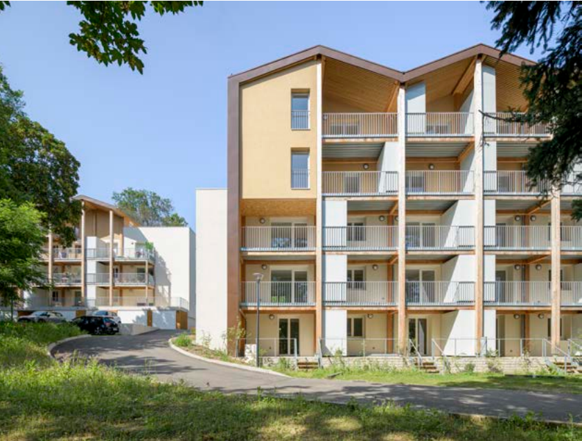
Les deux bâtiments existants sont complétés par une surélévation et une extension.
