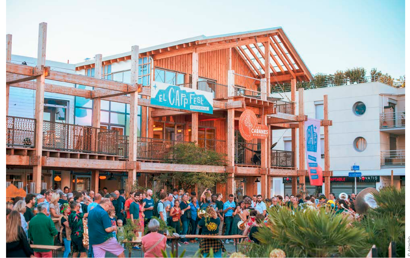
La structure poteaux-poutres en bois et le système d'assemblage ont été pensés pour favoriser l'adaptabilité, voire le démontage et le réemploi.
