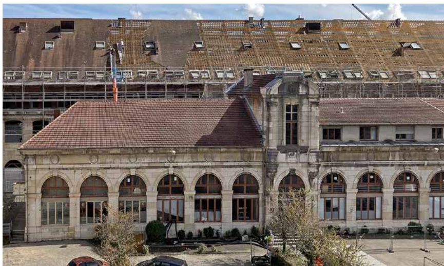
Les tuiles de l'Arsenal à Besançon resserviront pour le revêtement de sol du hall d'accueil.
