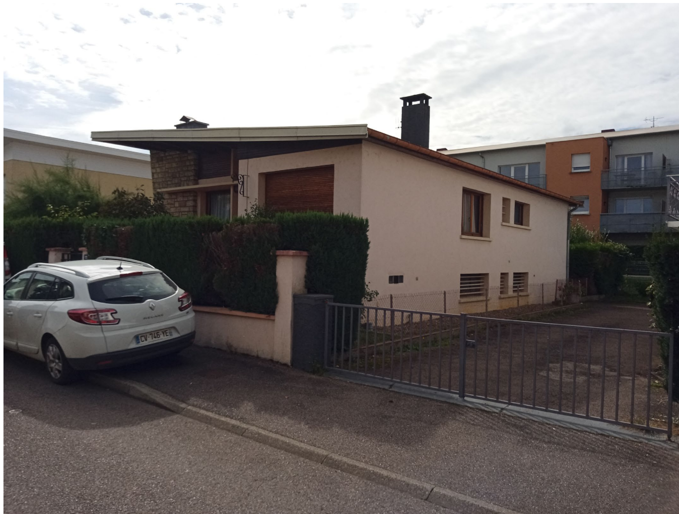
Maison 12 rue Pizard Theurey - Fiche N° 278 ITE - Entreprise CLERC - Audit énergétique et AMO - Sébastien DURY
