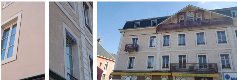
Jardinerie des Halles - Copropriété située place de la République à VESOUL - fiche N°120 (entreprises PIGHETTI et PARISOT )
