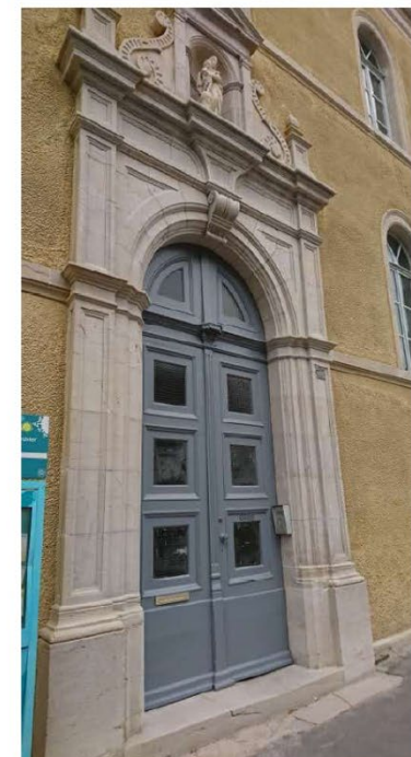
Ecole de musique - rue Baron Bouvier à Vesoul - Fiche N° 185 Reprises d'enduit à la chaux + badigeon à la chaux - Entreprises PIGHETTI, CLERC et PATEU-ROBERT)
