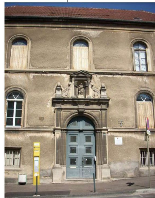
Ecole de musique - rue Baron Bouvier à Vesoul - Fiche N° 185 Reprises d'enduit à la chaux + badigeon à la chaux - Entreprises PIGHETTI, CLERC et PATEU-ROBERT)
