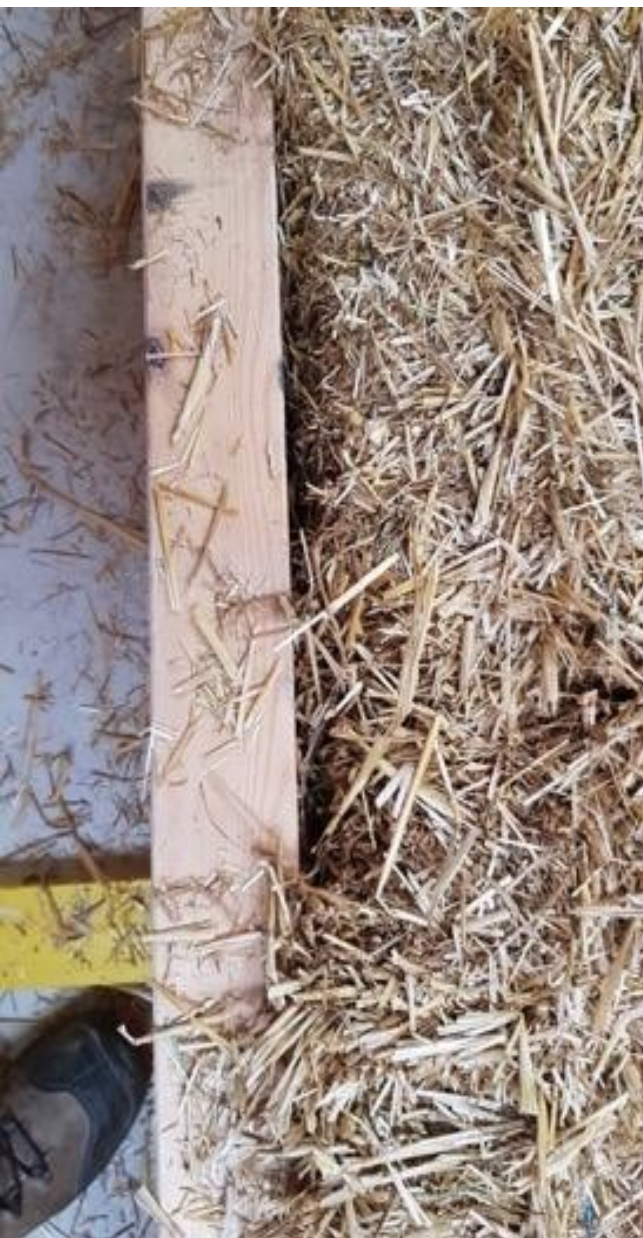
Vides entre montants et bottes de paille, chantier d'un groupe scolaire à proximité d'Arras (62)
