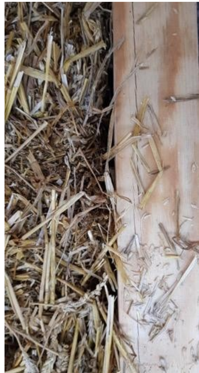
Vides entre montants et bottes de paille, chantier d'un groupe scolaire à proximité d'Arras (62)
