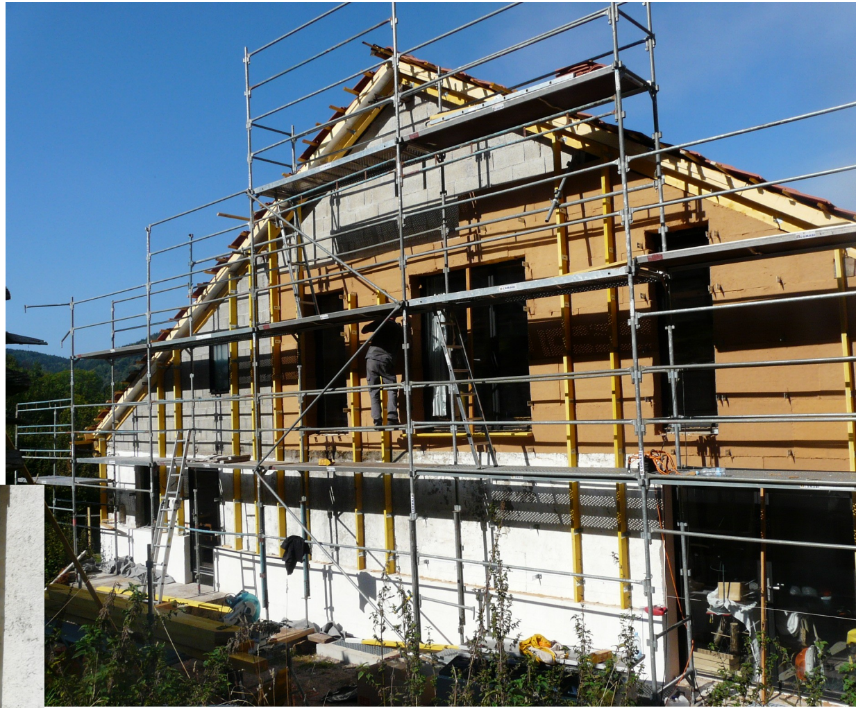
Pignon Sud-Est Démarrage ITE
