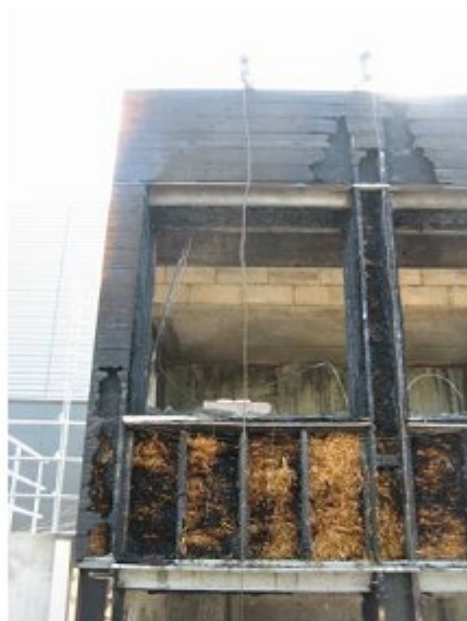
Vue des niveaux N+1 et N+2 (SUD)
