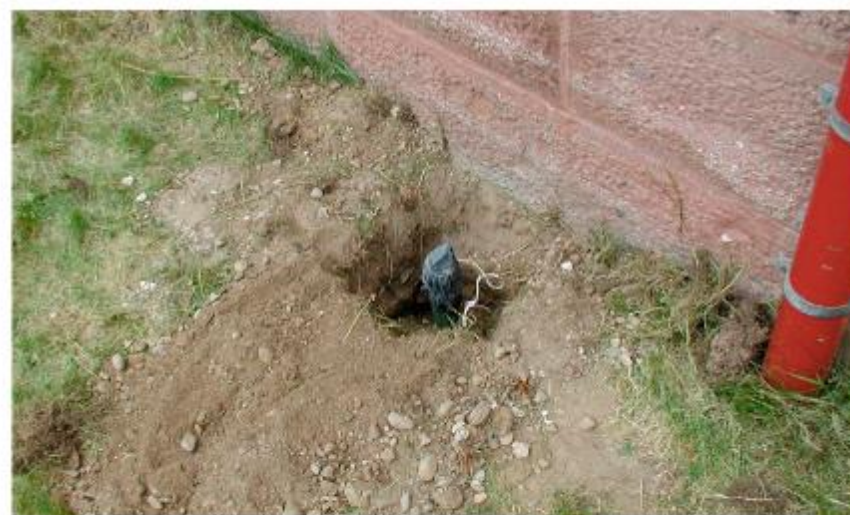
Figure 24 : Mise en place de la sonde de mesure en continu du radon (Barasol) 28
