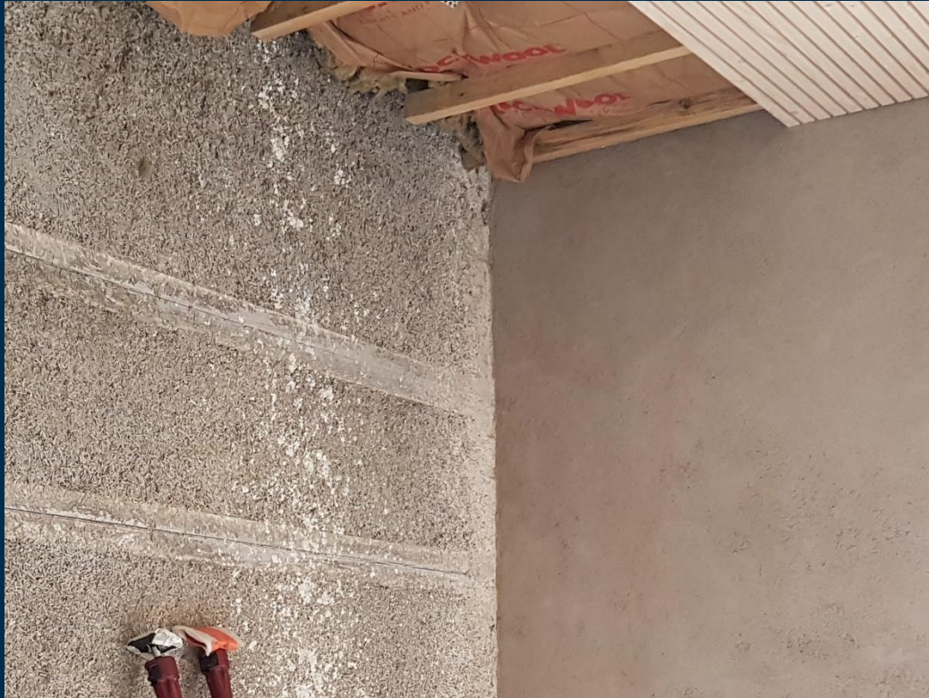
Chanvre apparent et enduit à la chaux
