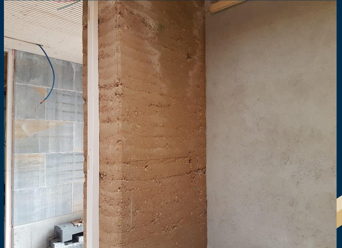
Pisé apparent et enduit à la chaux sur béton de chanvre
