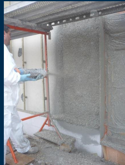
Mur en CHAUX & CHANVRE projeté à la machine
