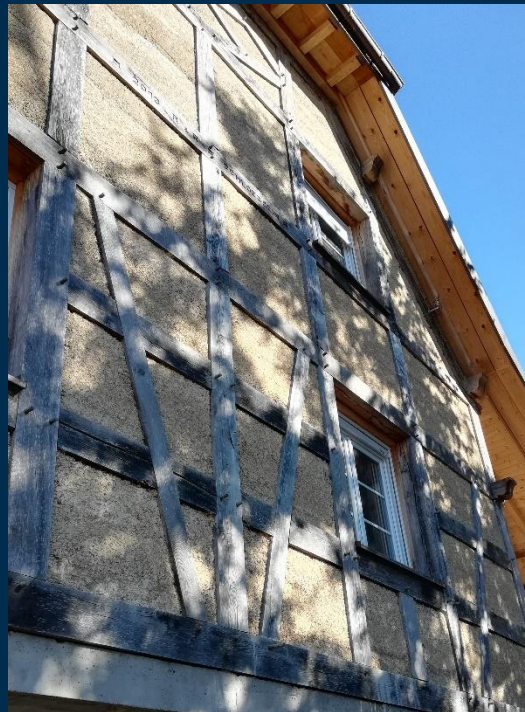
Mur banché colombage en CHAUX & CHANVRE
