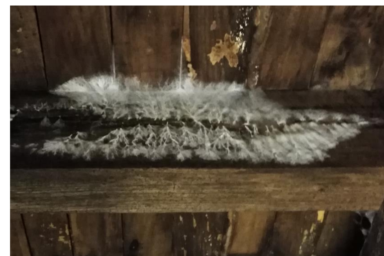
Exemple de mycelium sur un plancher de cave non-ventilée)
