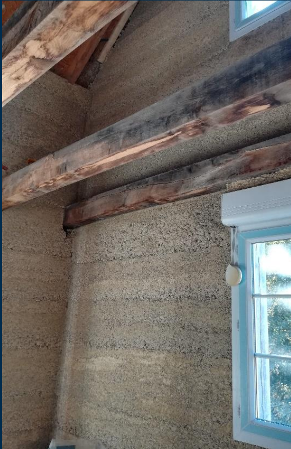
Mur banché en CHAUX & CHANVRE
