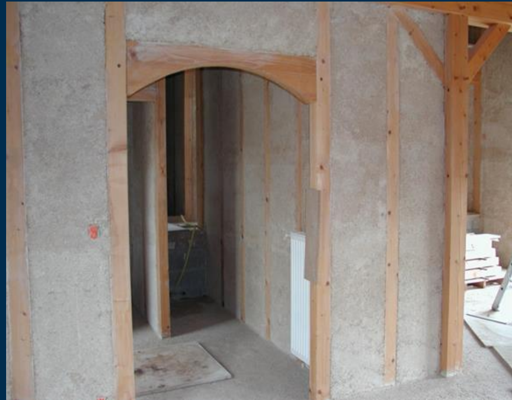
Cloisons de séparation en banché CHAUX & CHANVRE
