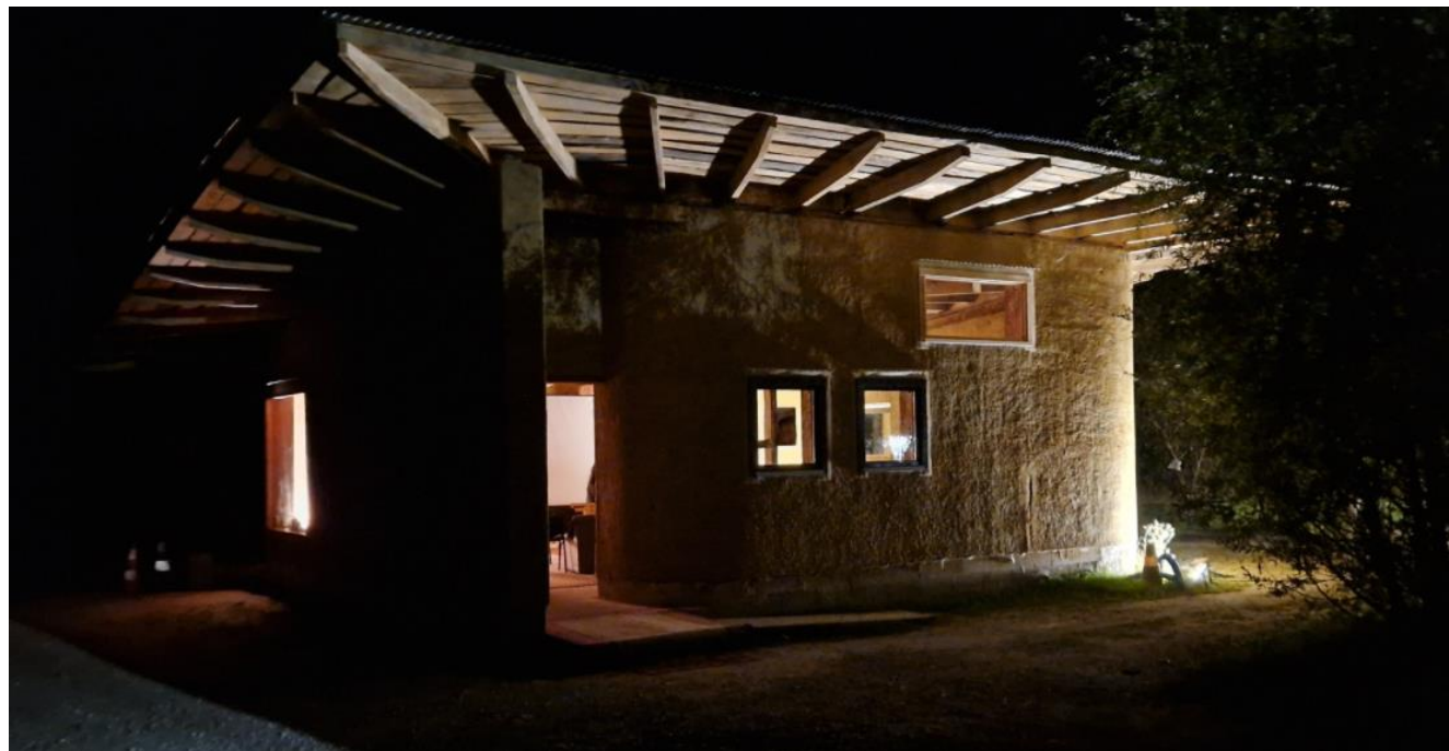
Lieu Commun pour la Californie TOUCY (89) : Maitrise d'ouvrage : Bonjour Cascade/ MOE: Ateliers Suspendus / Be Bois : JATOBA / Charpente: LABRICOOP / Terre-Paille : Michael STORTZ et Stéphane BOBEE
