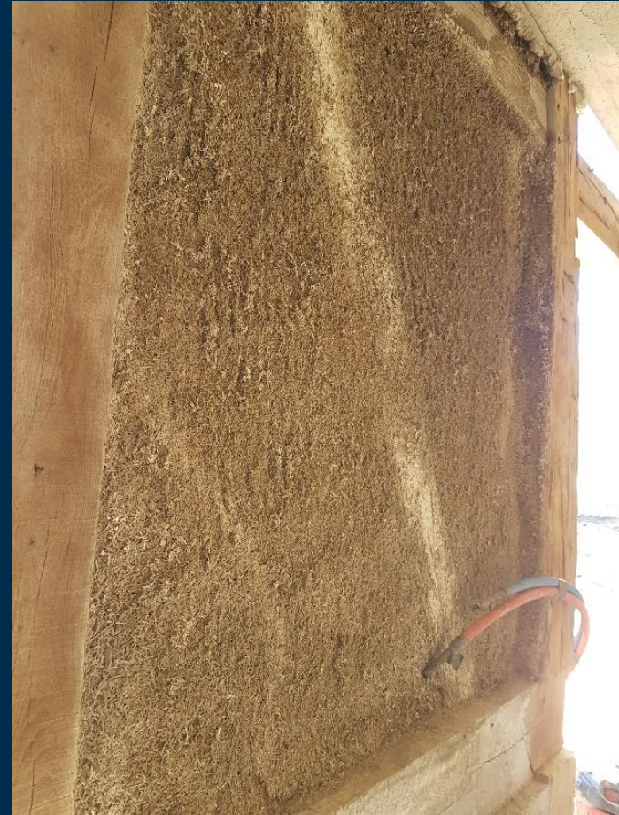
Mur en CHAUX & CHANVRE projeté à la machine
