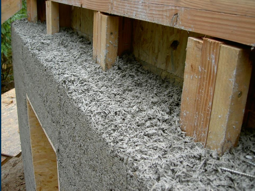
Mur en CHAUX & CHANVRE banché manuel
